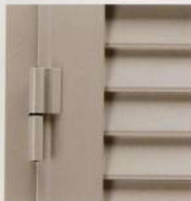
Dettaglio cerniera telaio.
