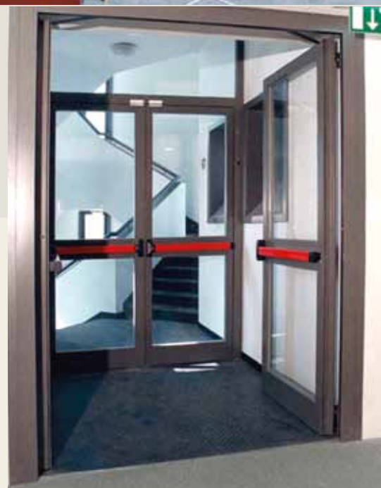
Vetrata tagliafuoco in alluminio a due ante complessa, verniciata Ral 8017, composta da un soprauce fisso, con doppio maniglione antipanico a barra rossa.
