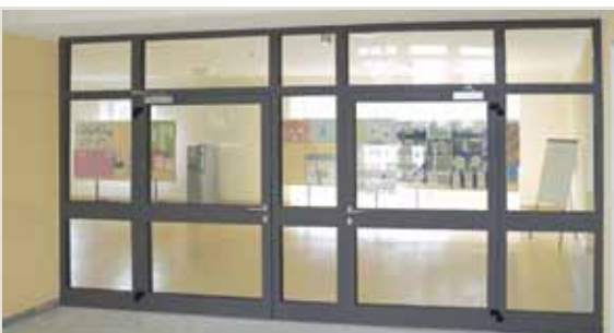
Vetrata tagliafuoco in alluminio, verniciata Ral 7016, composta da due fianchi luce fissi, da un soprauce fisso e da due aperture ad una anta.
