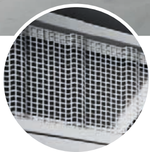
Particolare del sopra luce oltre l'anta mobile in lamiera fori quadri 8x8 mm.
