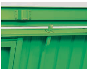
Vista interna serratura standard con 1 punto di chiusura centrale per struttura Spazio.
